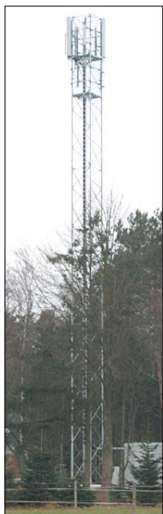
Das ist der umstrittene Mobilfunkmast.
